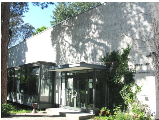
Alexander-von-Humboldt-Haus der Gesellschaft für Erdkunde, Arno-Holz-Straße 14, Steglitz
