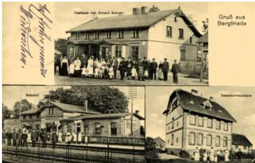
Bergfriede, Gasthaus Eduard Ketz, Bahnhof, Beamtenwohnhaus
