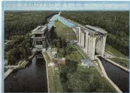
Die moderne Anlage aus Beton und Stahl ist mit neuer, digitaler Technik versehen – von hier aus können Schiffe 36 Meter hochgehievt werden
