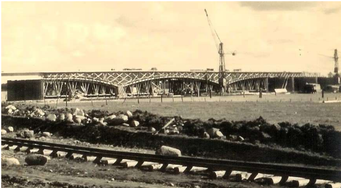
Die Brücke während der Bauarbeiten 4
